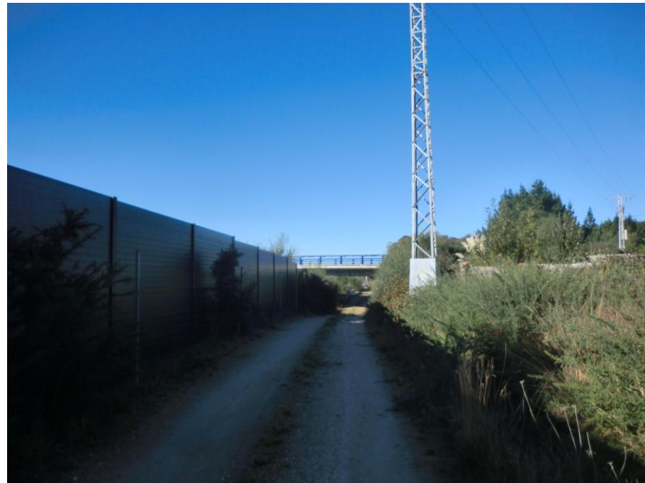
Foto 13: Margen derecha. Pantallas acústicas.
