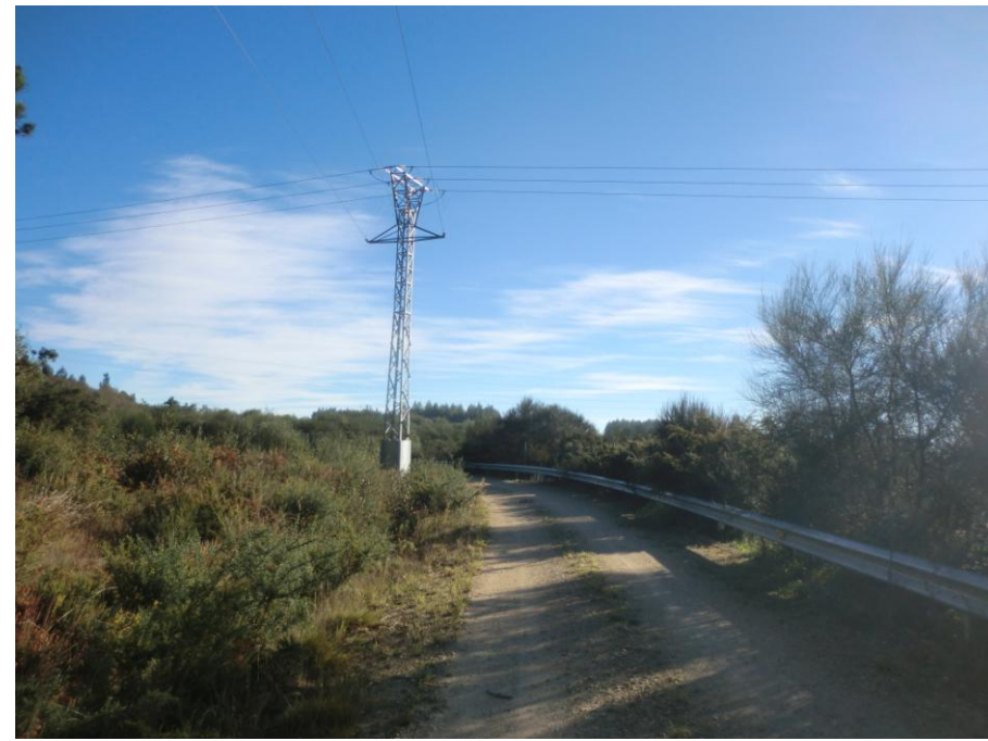
Foto 14: Margen derecha. Líneas eléctricas.
