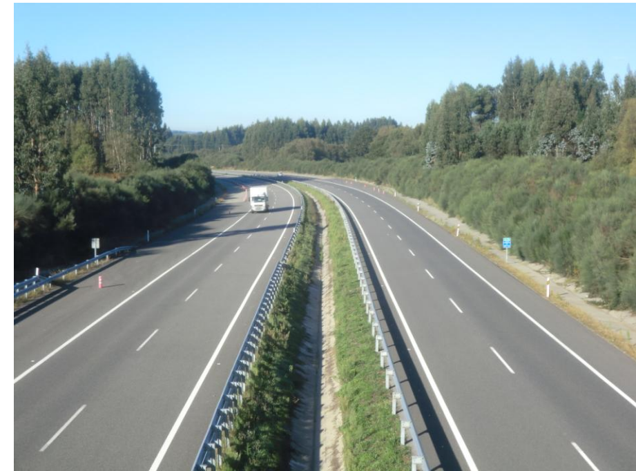
Foto 10: Margen izquierda. Vista carriles.
