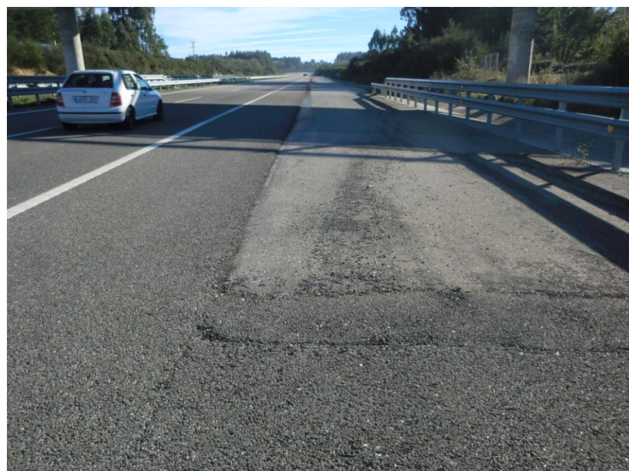
Foto 21: Margen izquierda. Detalle firme carril deceleración.
