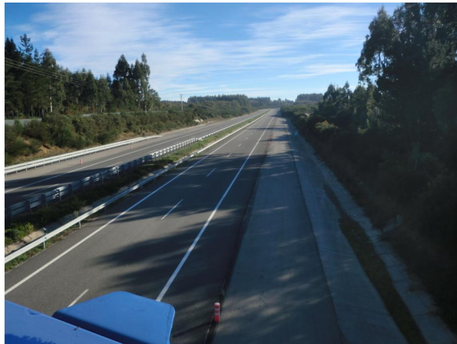
Foto 11: Margen izquierda. Vista carril y cuneta.
