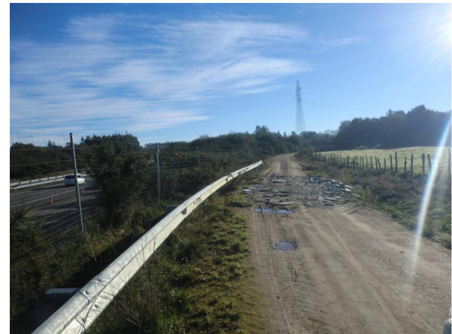
Foto 4: Margen izquierda. Torre de alta tensión en semiárea.
