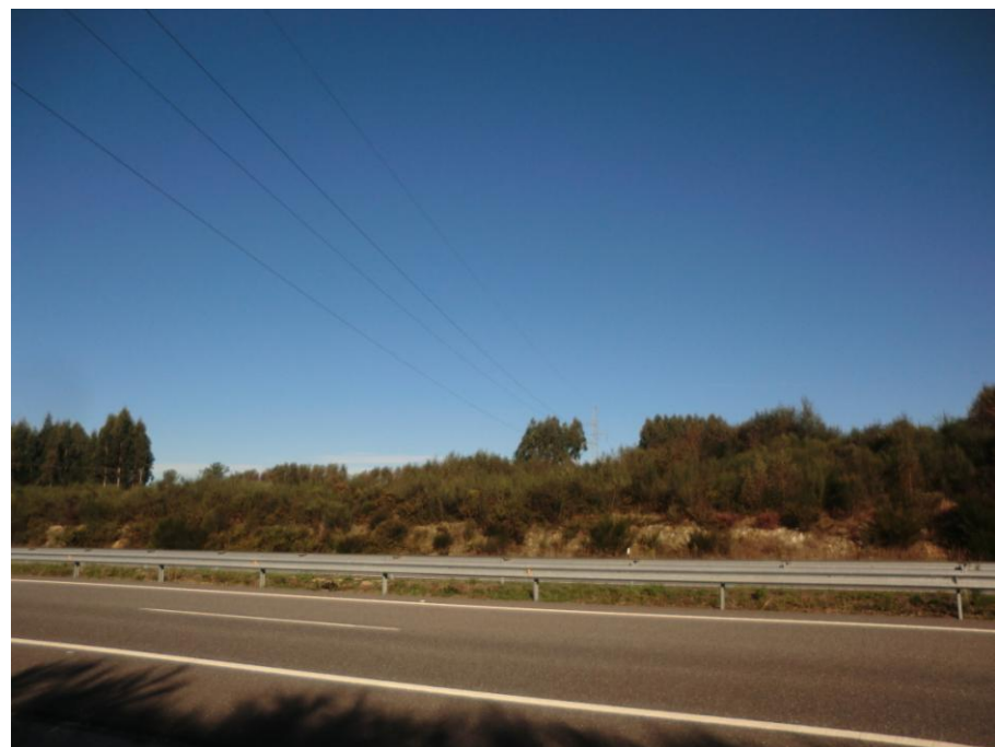
Foto 23: Línea de alta tensión cruzando la autovía.
