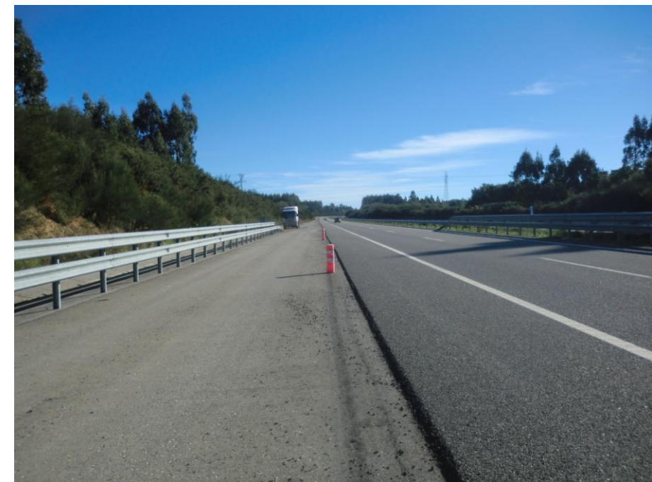
Foto 36: Margen derecha. Carril aceleración.
