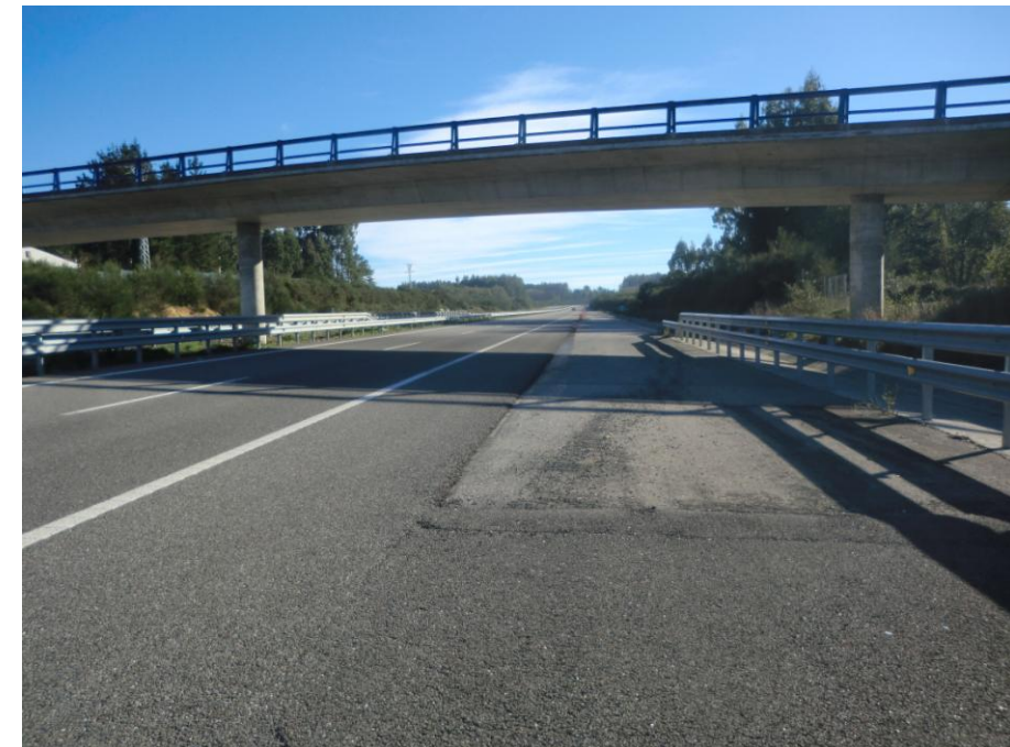
Foto 20: Margen izquierda. Inicio carril deceleración.
