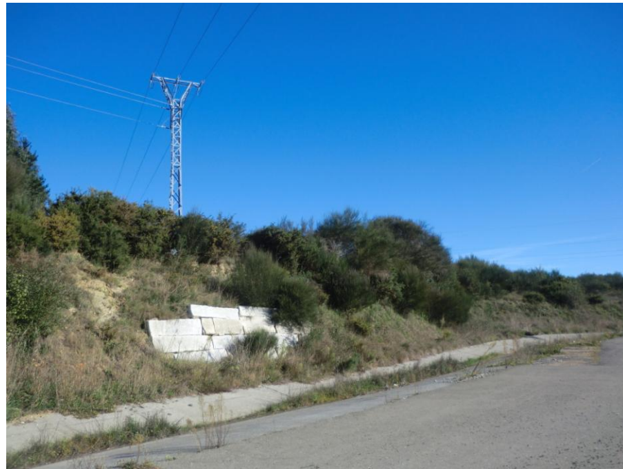
Foto 35: Margen derecha. Muro.
