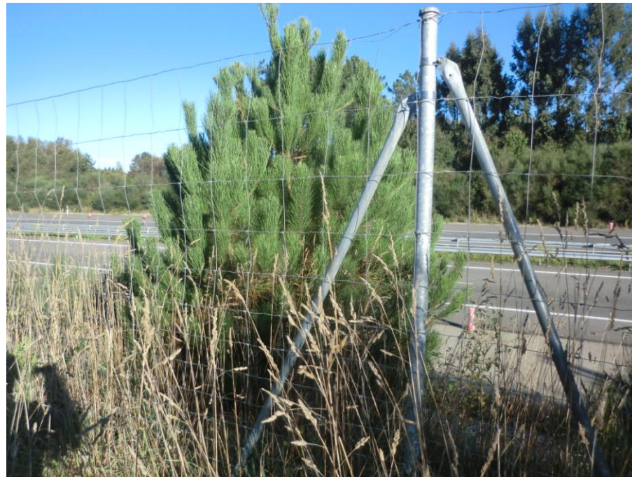
Foto 9: Margen izquierda. Detalle cierre próximo a carril de deceleración.
