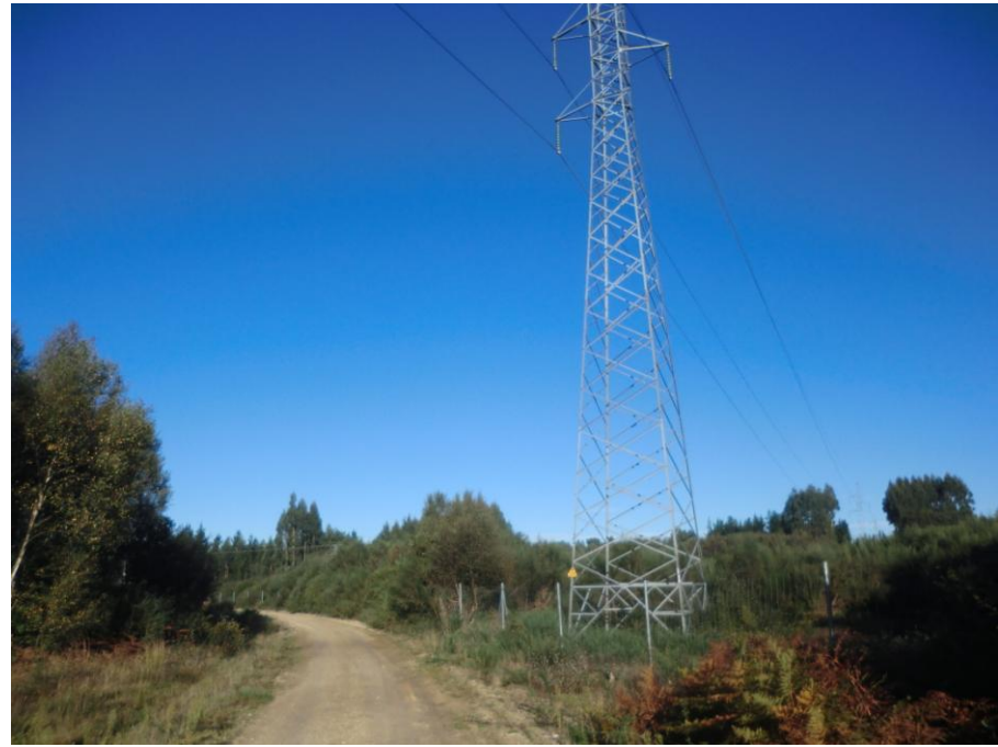
Foto 5: Margen izquierda. Torre de alta tensión en semiárea.
