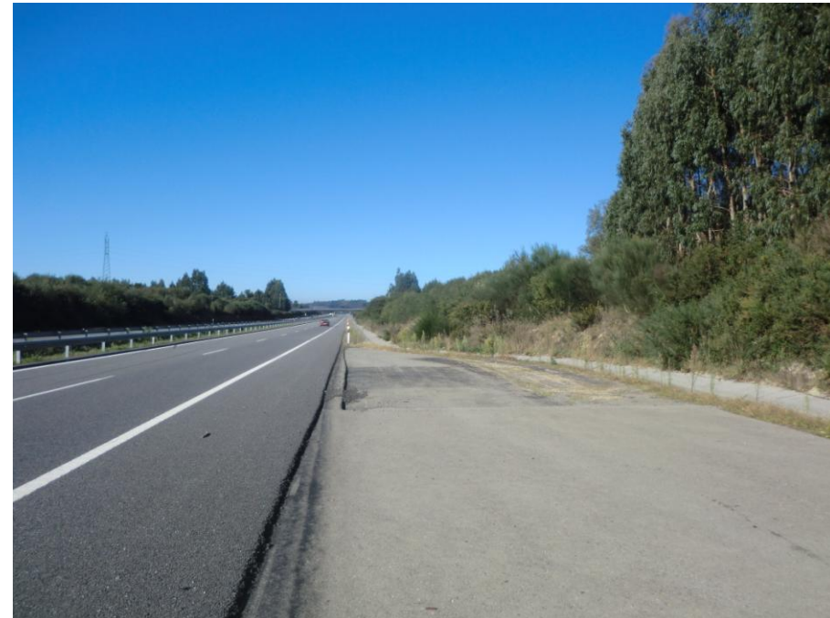
Foto 32: Margen derecha. Fin carril deceleración.
