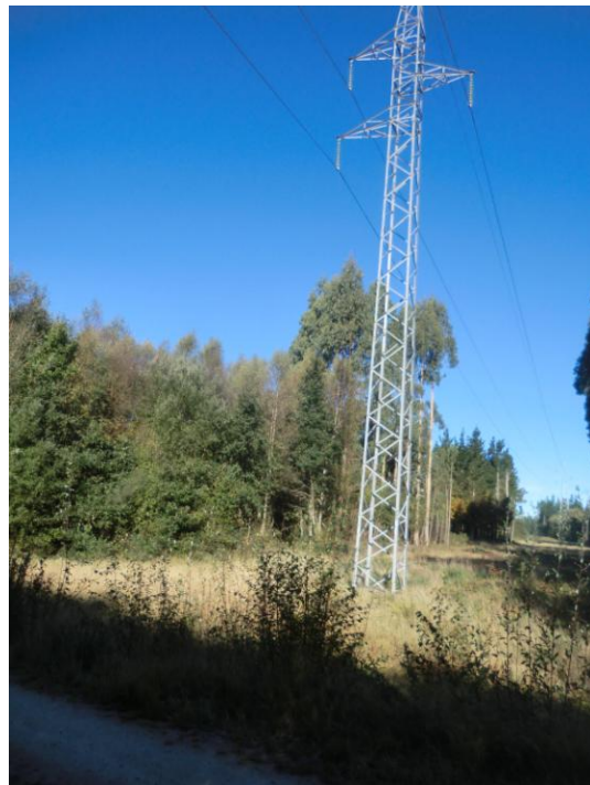
Foto 15: Margen derecha. Línea de alta tensión.
