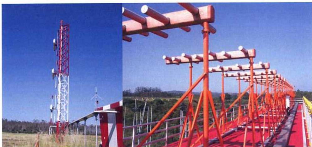
Ilustración 2.16.- VOR/ DME y localizador de la pista 35
