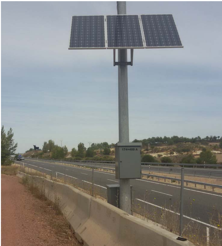
Cámara Vigilancia afectada
