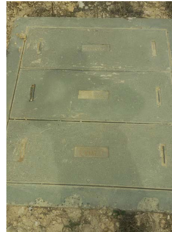
Arqueta de servicios existentes
