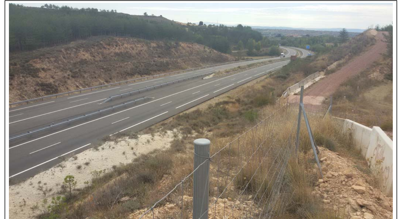
Vista desde talud a rectificar
