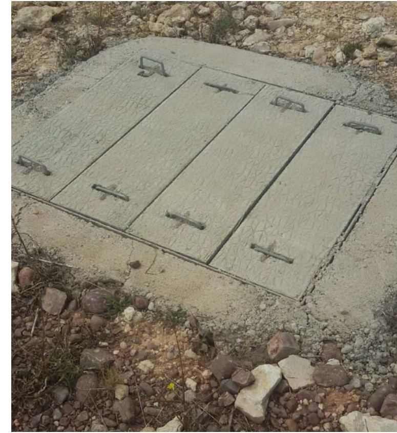
Arqueta de servicios existentes
