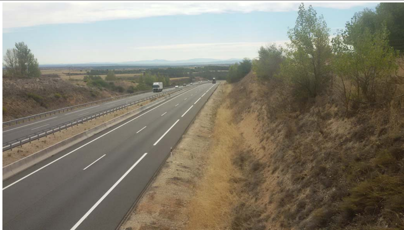
Vista desde puente de camino existente
