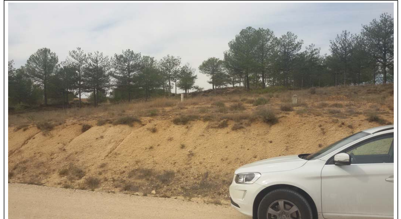
Vista de talud existente en camino actual
