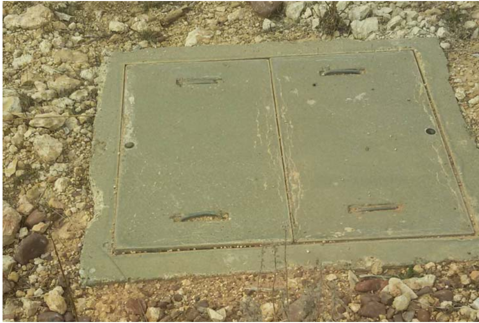
Arqueta de servicios existentes
