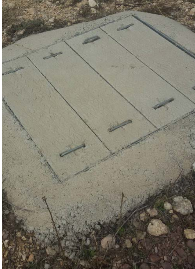
Arqueta de servicios existentes
