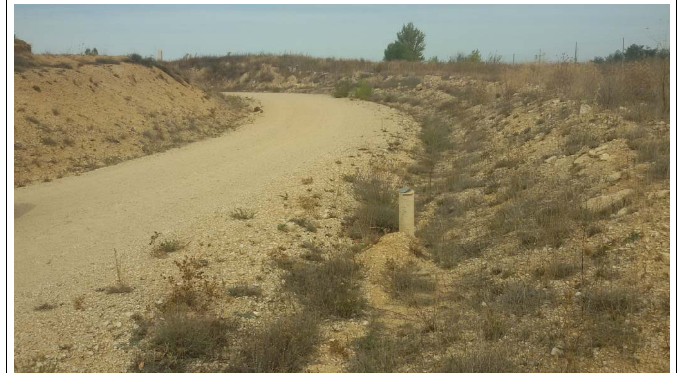
Vista camino existente en zona de PS
