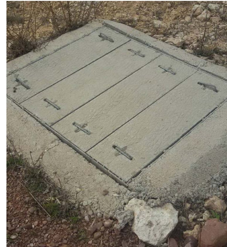
Arqueta de servicios existentes
