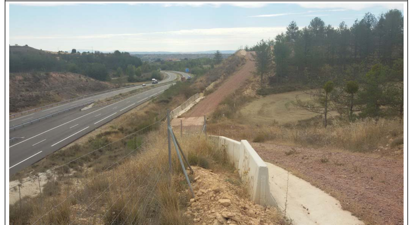
Vista desde talud a rectificar
