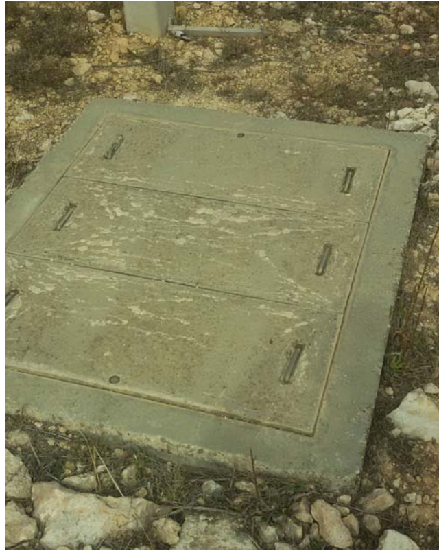
Arqueta de servicios existentes
