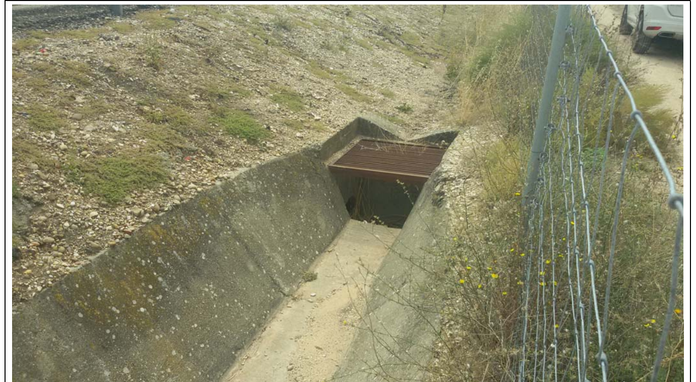
Cuneta existente en autovía
