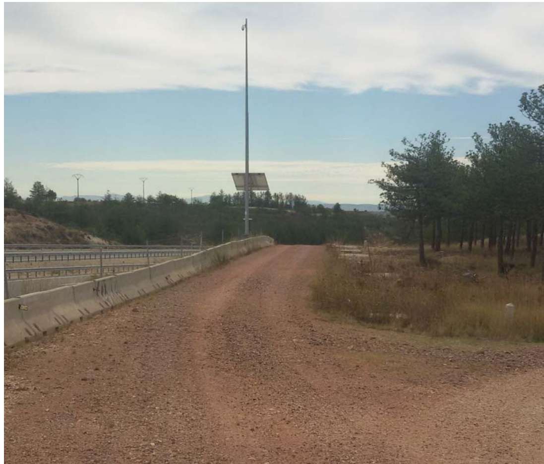
Vista camino existente afectado
