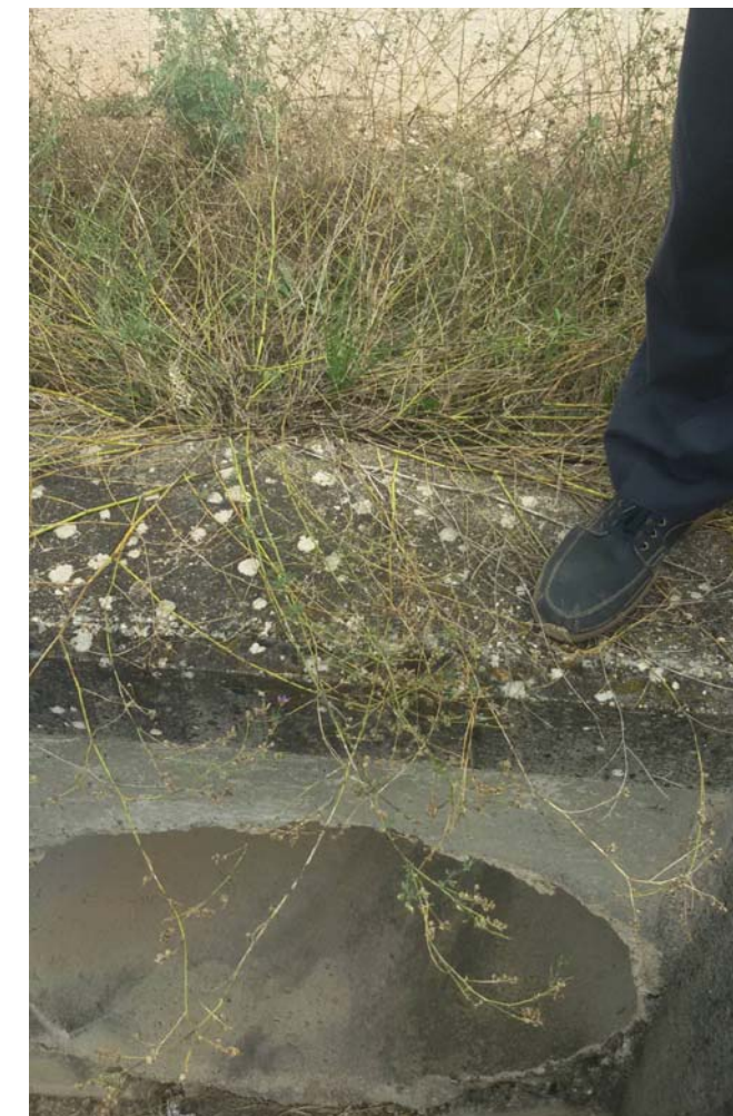
Tubo de drenaje en camino existente 1,0 m
