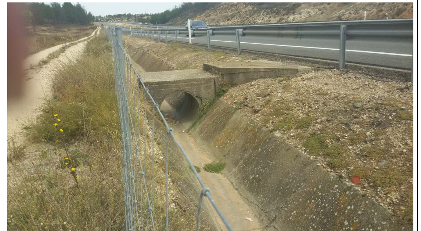
Cuneta existente en autovía
