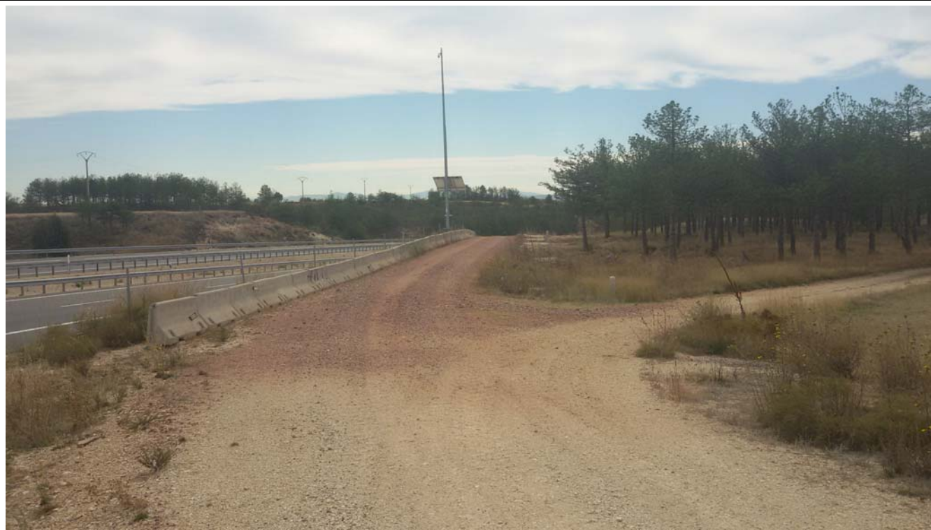
Vista camino existente afectado
