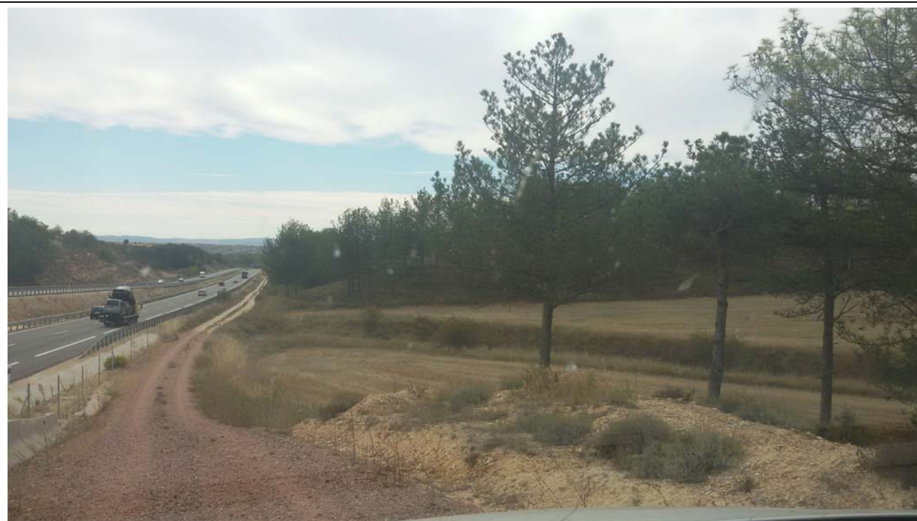
Pinar afectado por ubicación AS
