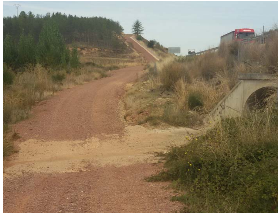
Vista camino y ODT autovía
