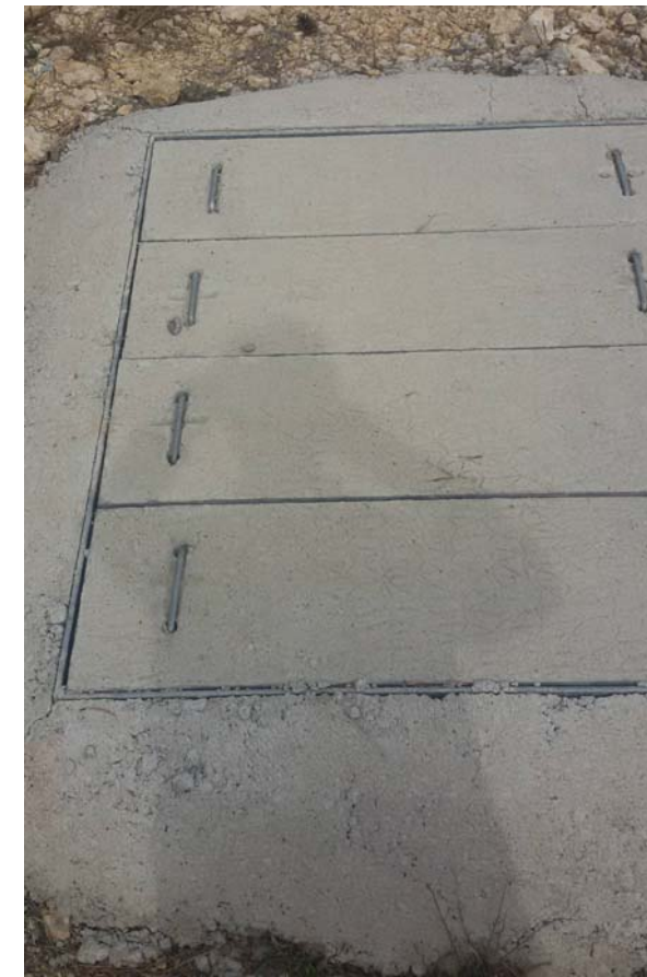
Arqueta de servicios existentes
