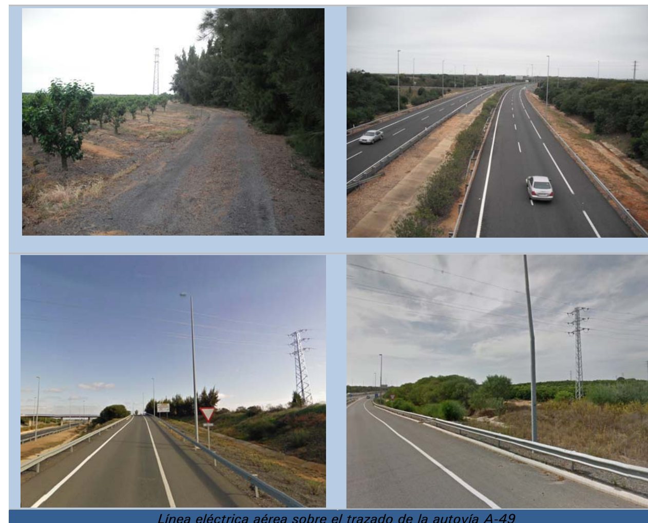
Línea eléctrica aérea sobre el trazado de la autovía A-49
