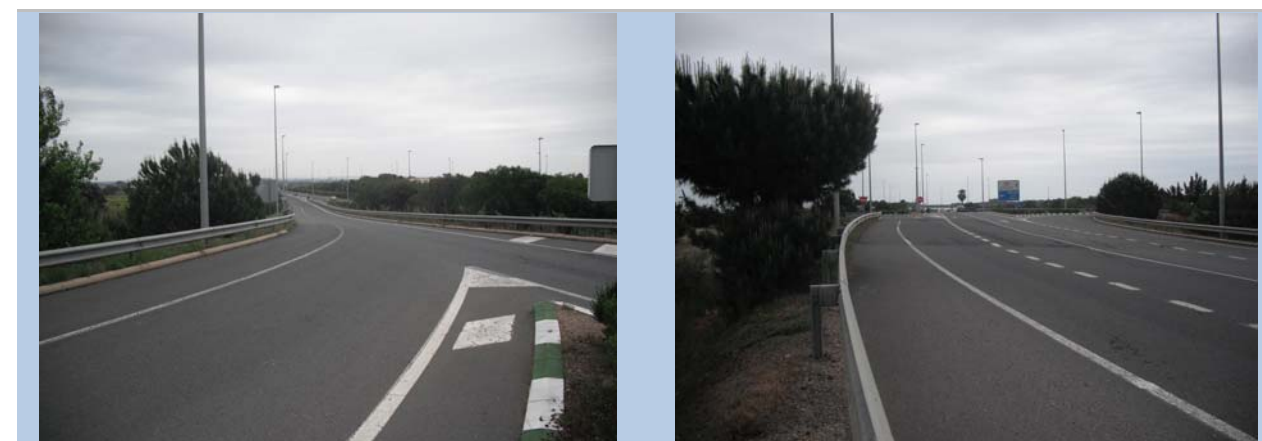
Red de alumbrado en el enlace de Lepe Oeste de la autovía A-49
