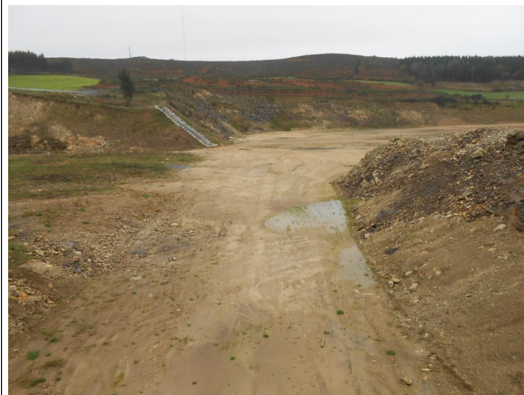
Foto 35: Vista bajante escalonado.
