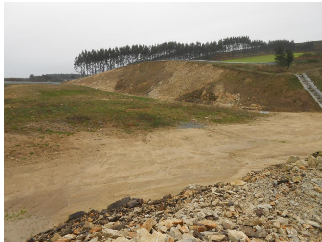
Foto 40: Vista taludes y bajante.
