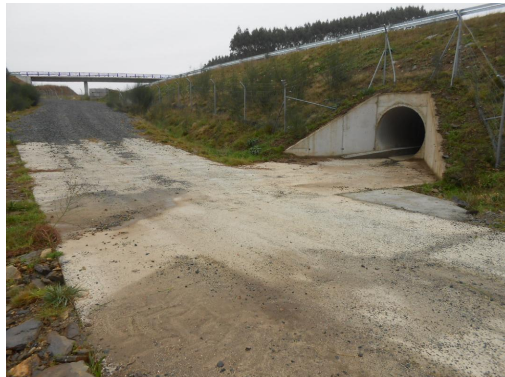
Foto 48: Obra de drenaje transversal del tronco de la autovía.
