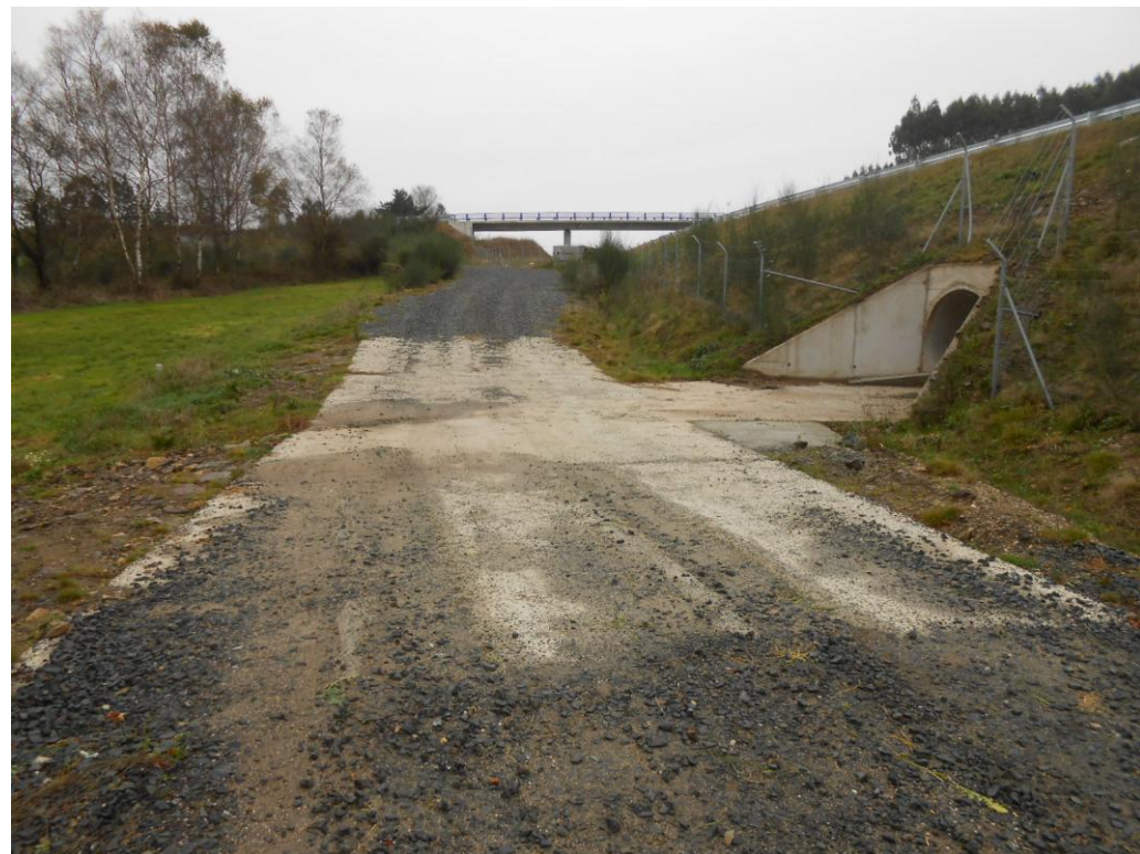
Foto 47: Obra de drenaje transversal del tronco de la autovía.
