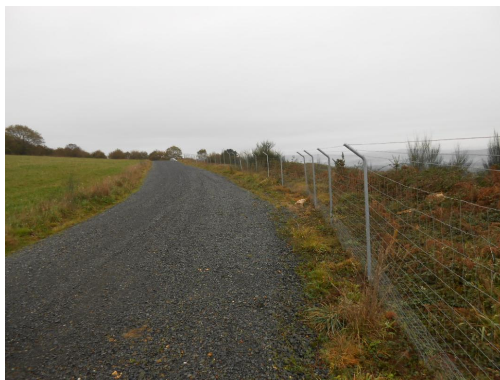
Foto 53: Detalle cierre perimetral.
