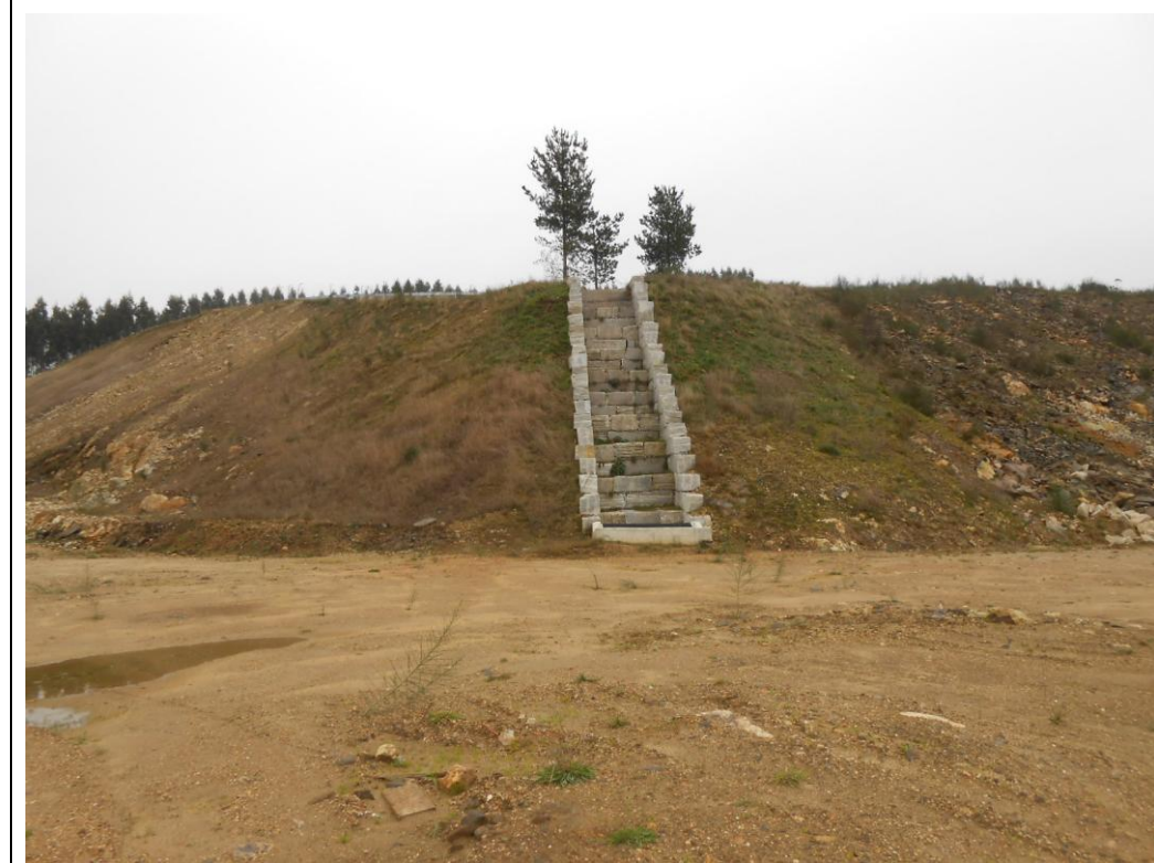
Foto 18: Detalle bajante escalonada.
