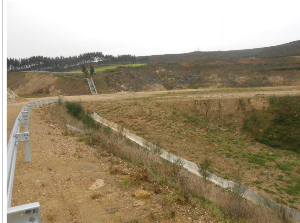
Foto 28: Cuneta bajo talud del carril de deceleración margen izquierda.
