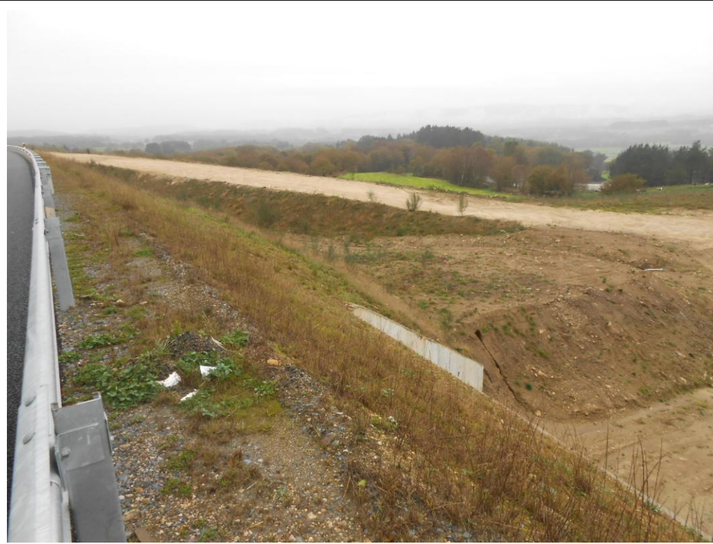
Foto 61: Vista a la salida del paso inferior.
