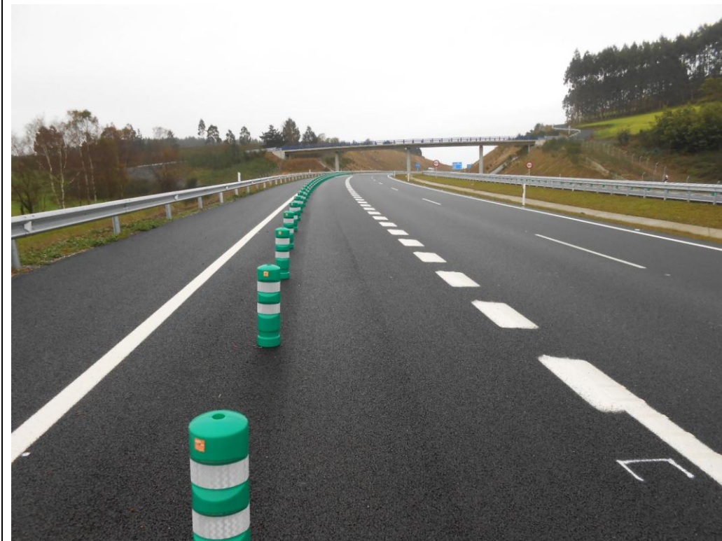
Foto 56: Carril deceleración margen derecha asfaltado.
