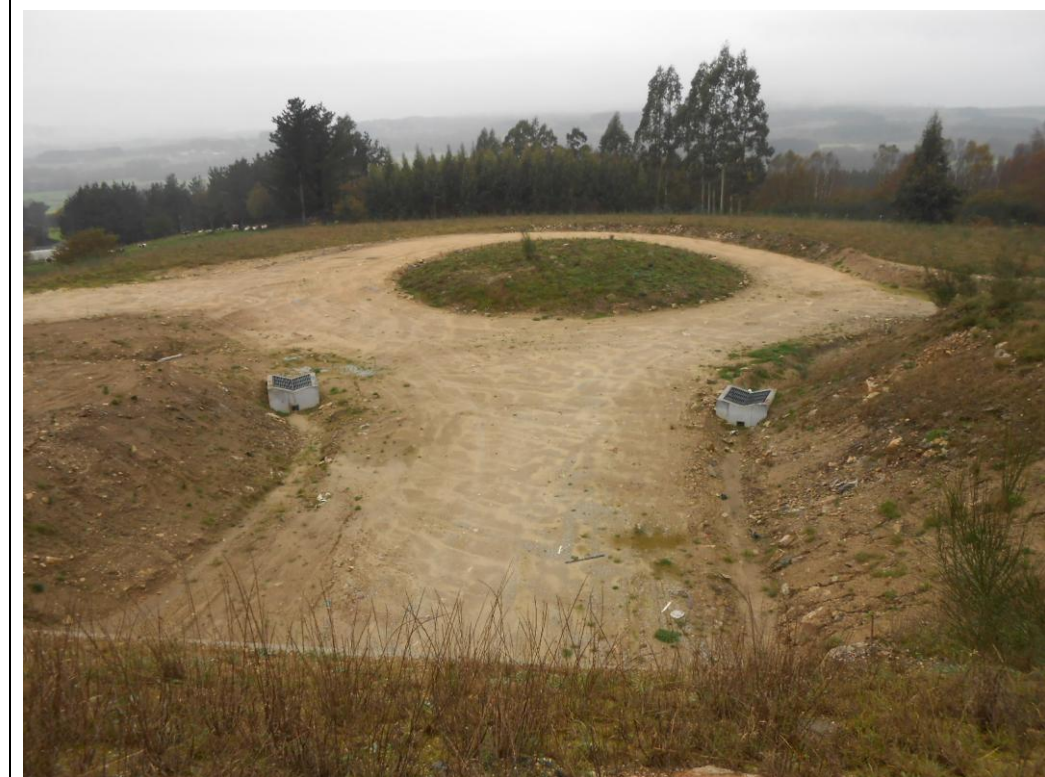
Foto 60: Glorieta de conexión de carriles de aceleración, deceleración y vía del paso inferior, margen derecha. Detalle de sumideros.
