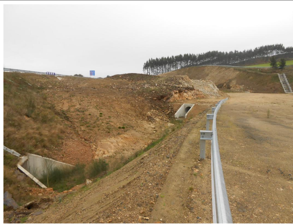
Foto 25: Obras de drenaje transversal.
