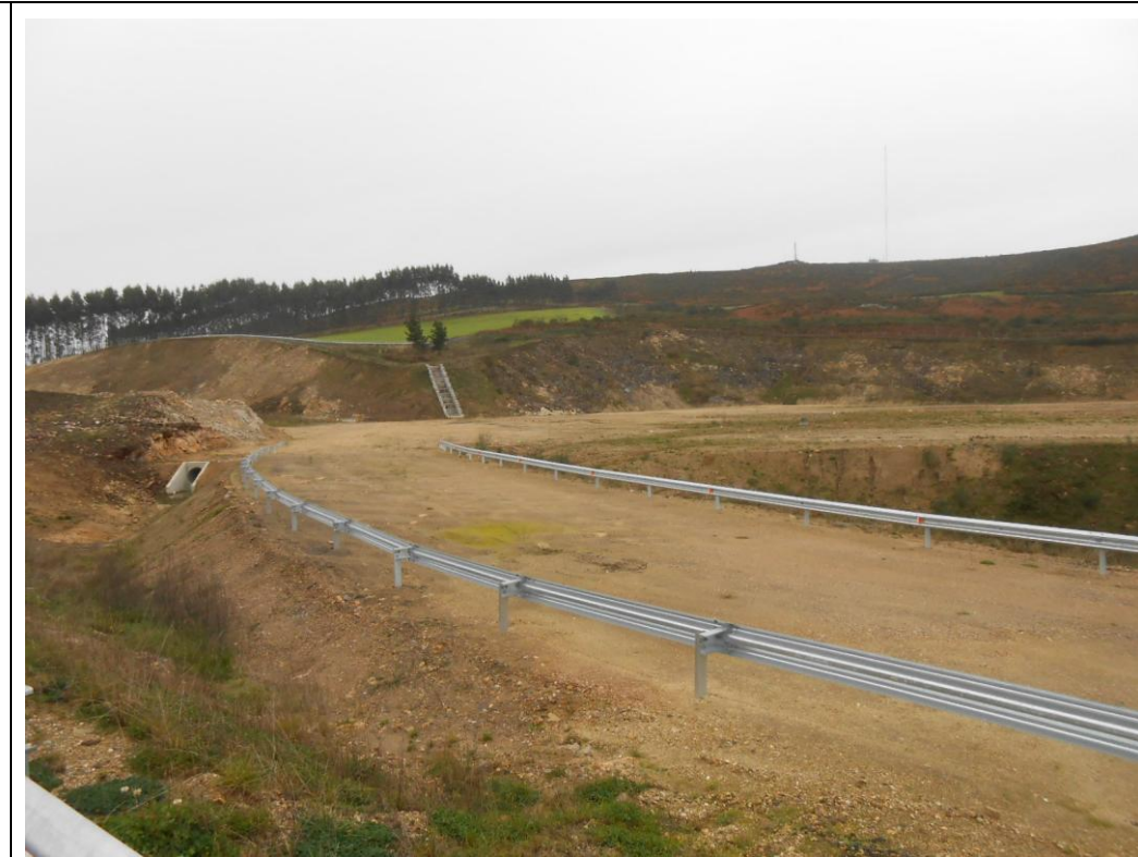
Foto 34: Carril deceleración margen izquierda tramo sin asfaltar y vista de ODT y bajante escalonado.
