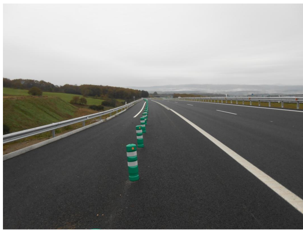
Foto 29: Carril deceleración margen izquierda asfaltado.
