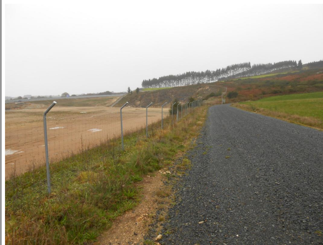
Foto 54: Detalle cierre perimetral.
