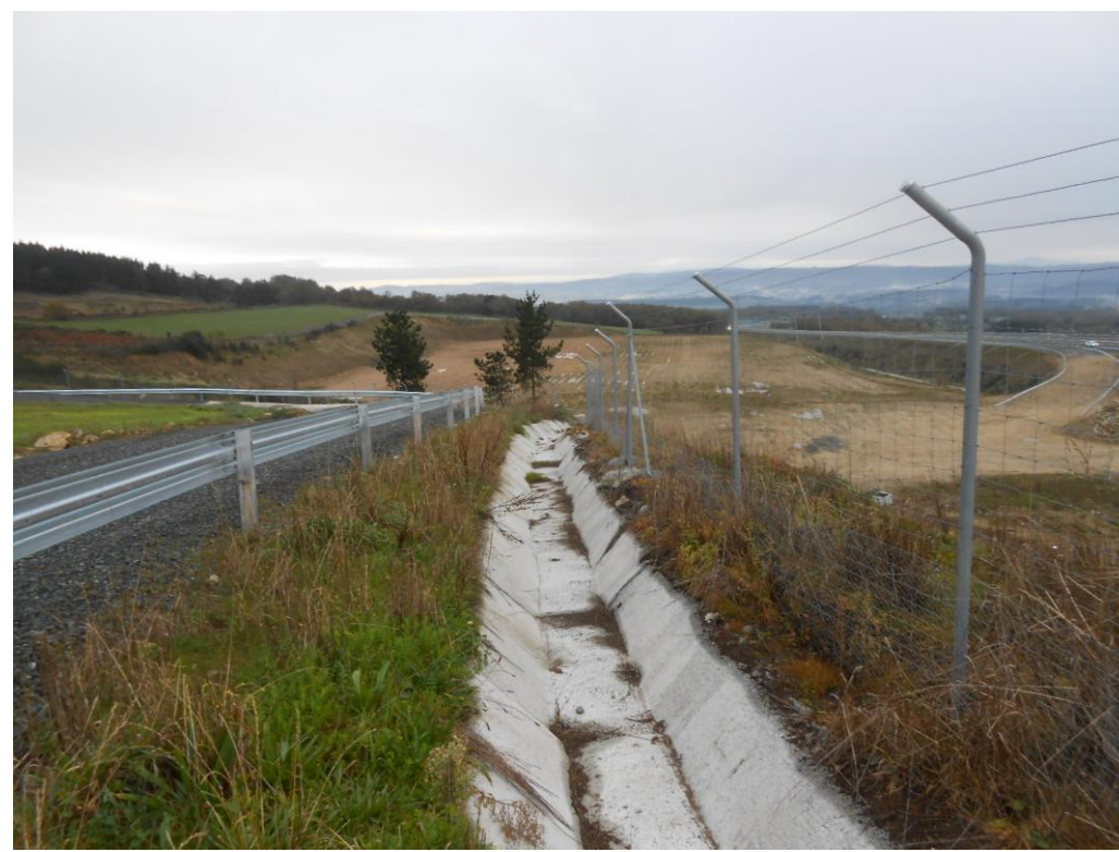
Foto 6: .Detalle valla perimetral de la autovía.
