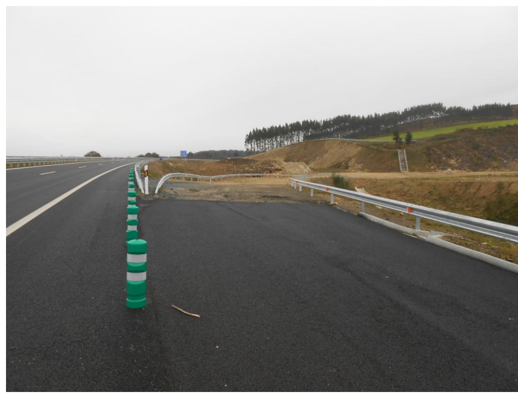
Foto 30: Carril deceleración margen izquierda asfaltado.
