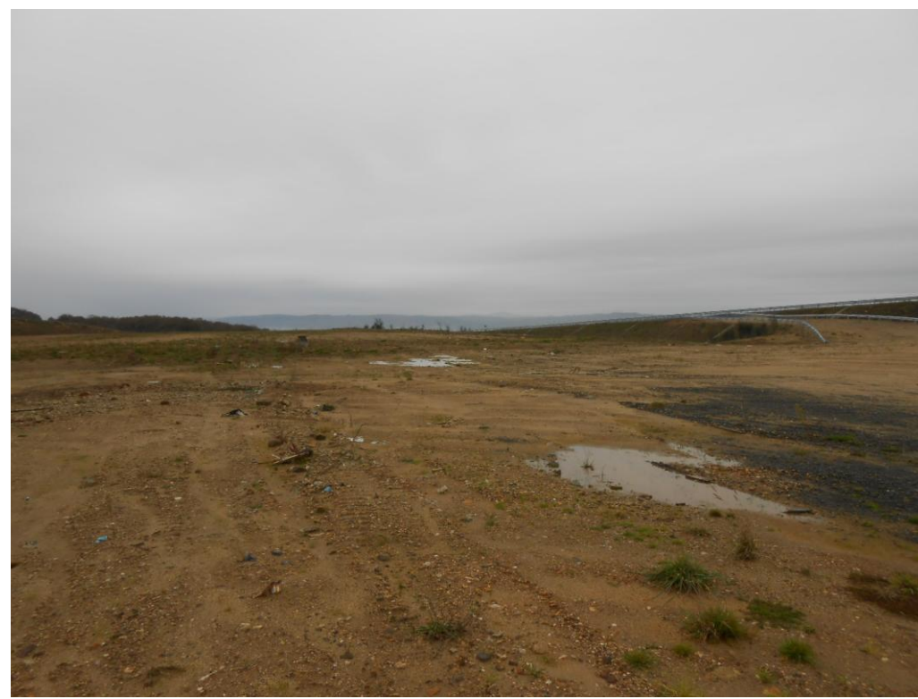
Foto 22: Vista explanada y final de carril deceleración margen izquierda.
