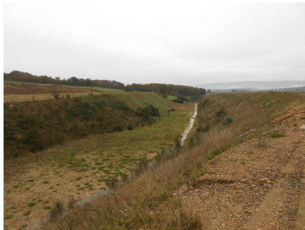
Foto 27: Cuneta pie de terraplén del tronco de la autovía.
