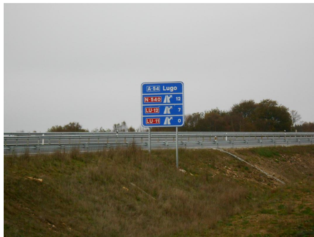
Foto 43: Talud del tronco de la autovía con bajantes señalización.
