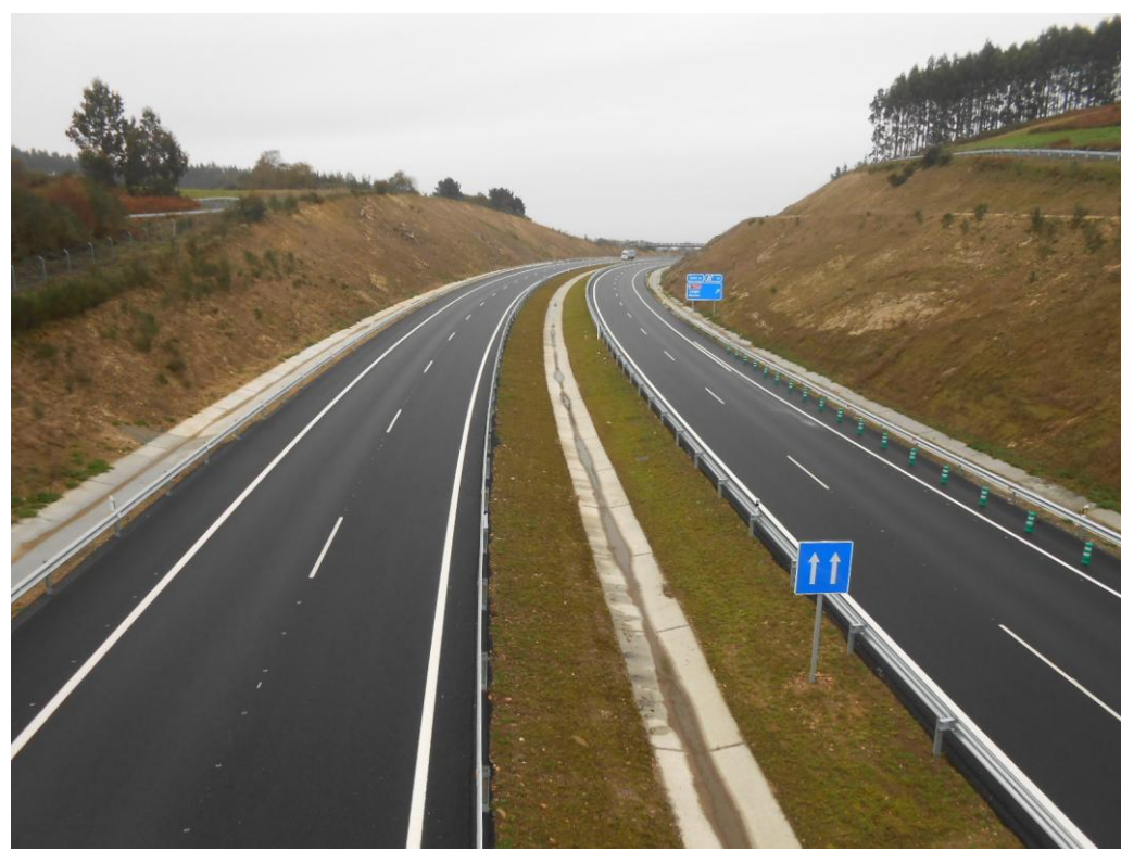
Foto 45: Tronco de la autovía.
