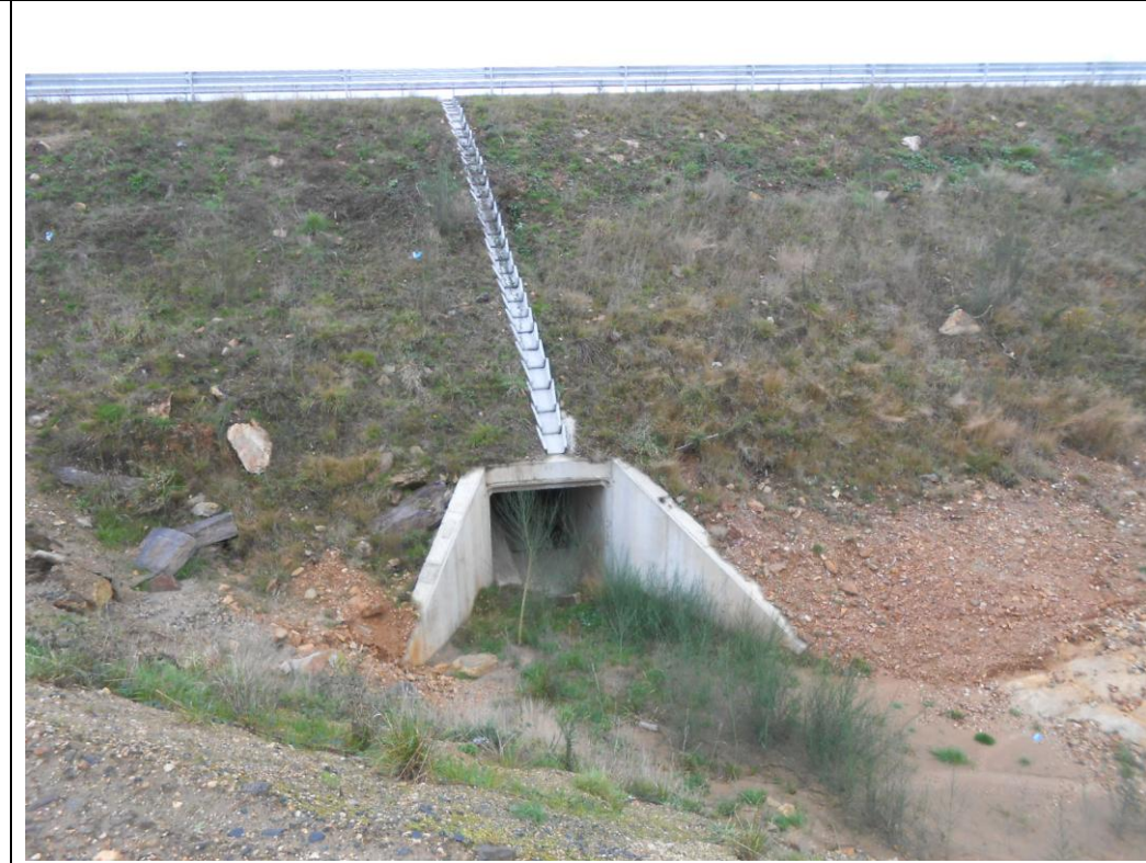
Foto 26: Obras de drenaje transversal y bajante prefabricada.
