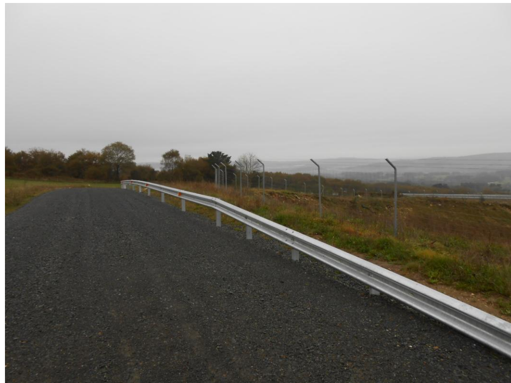
Foto 55: Detalle cierre perimetral.
