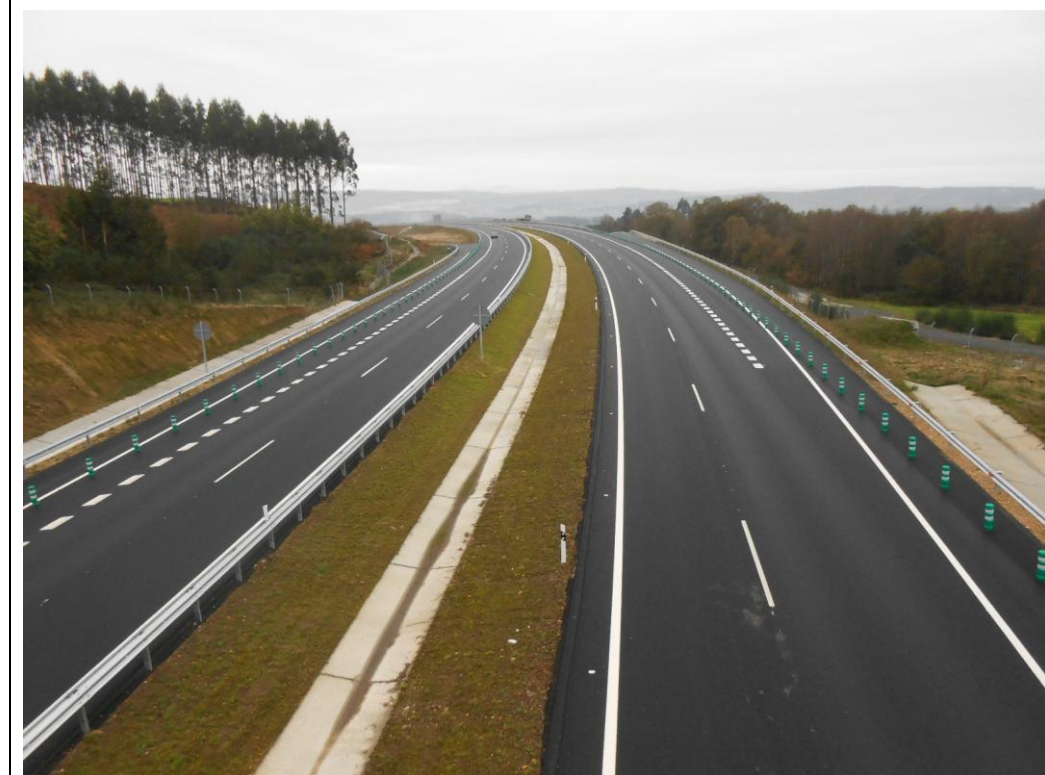
Foto 44: Tronco de la autovía.
