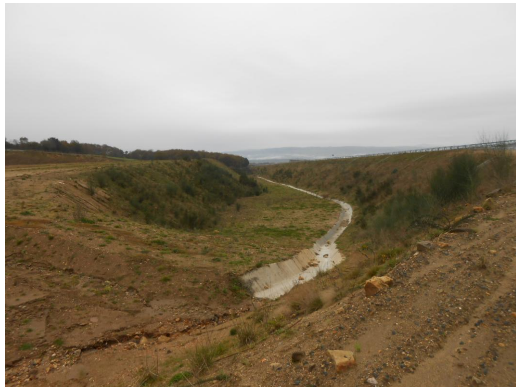
Foto 23: Detalle cuneta pie de terraplén y explanada.
