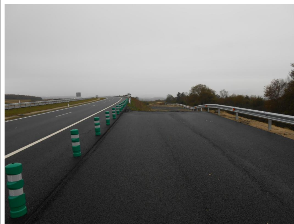
Foto 57: Carril deceleración margen derecha asfaltado.
