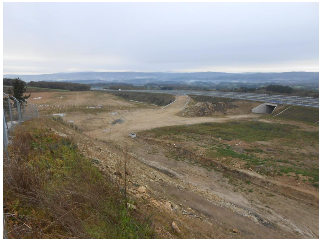
Foto 7: Vista carril de deceleración, aceleración y vía de comunicación bajo paso inferior margen izquierda.
