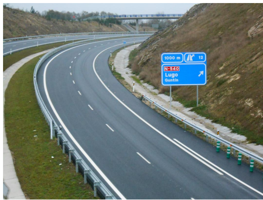
Foto 46: Tronco de la autovía.
