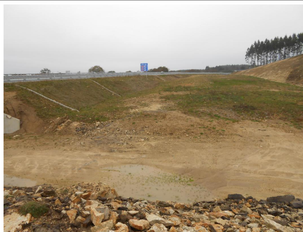
Foto 41: Bajantes del talud del tronco de la autovía.
