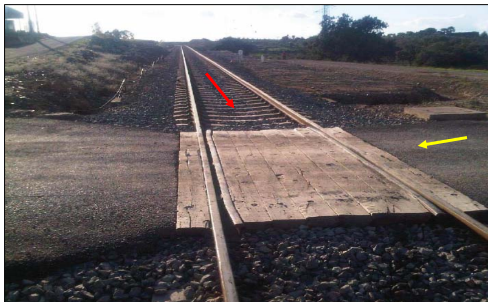
Vista hacia el lado Huelva. (Fuente: Adif)
