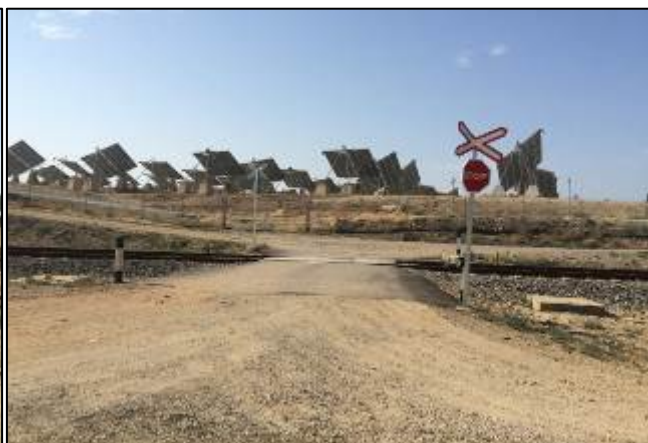
Acceso al paso por el margen derecho, según el sentido de circulación del tren.
