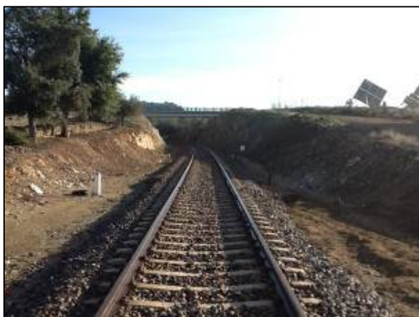
Vista desde el paso a nivel hacia el lado Madrid.
