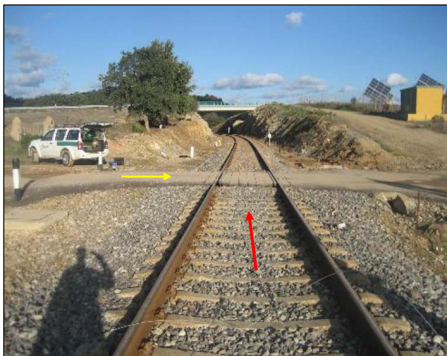
Vista hacia el lado Madrid. (Fuente: Renfe)
