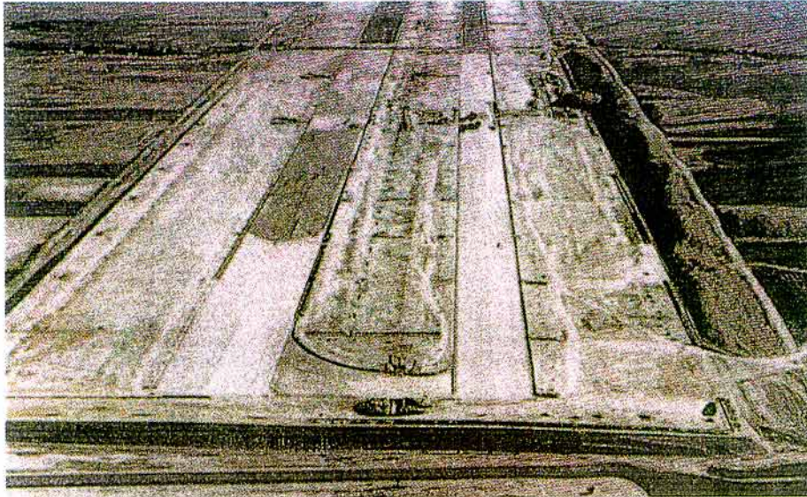
Ilustración 2.6. Construcción de la pista 18R-36L
