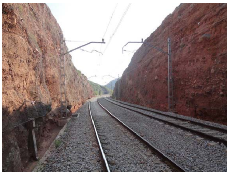
Vista sentido Barcelona. Malla antidesprendimientos en el PK 323+300.
