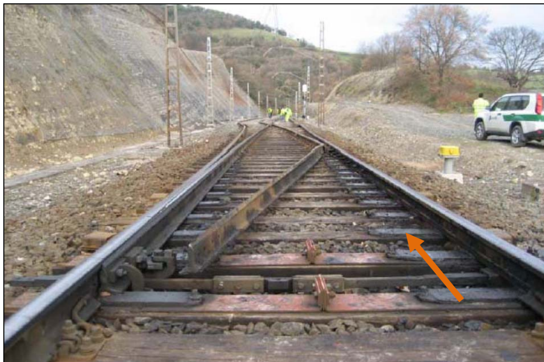
Vista del desvío nº 1 de entrada a Lezama. (Fuente Adif)
