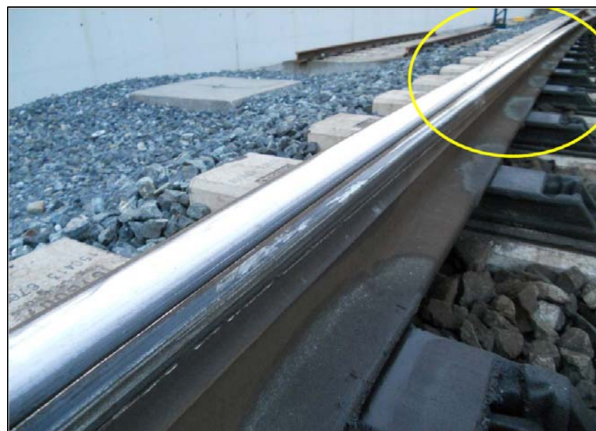
Punto "0" PK 17+896. Fuente Adif
