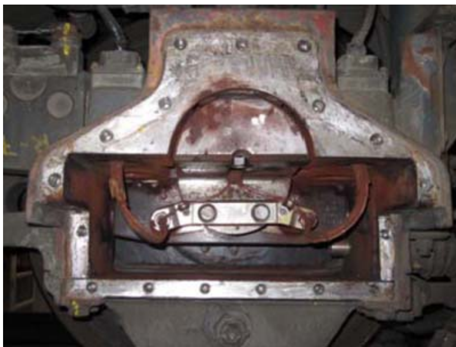
Rueda izquierda (descarrilada) del eje 8º. (Fuente Renfe: Operadora)
