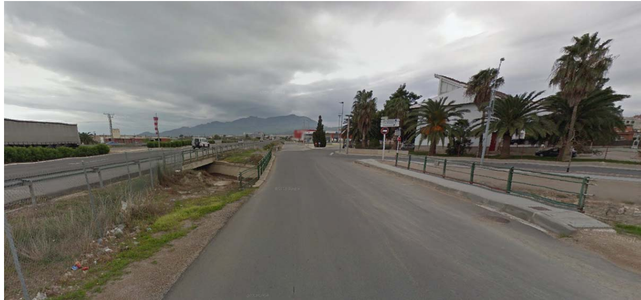
Vista de la obra de paso del Canal Maritim y zona urbana en el lado oeste en la zona final del límite de actuación meridional.
