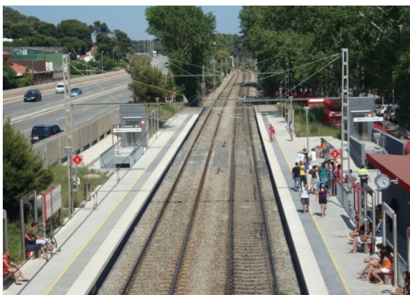
Vista del apeadero de Platja de Castelldefels (fuente: CIAF)
