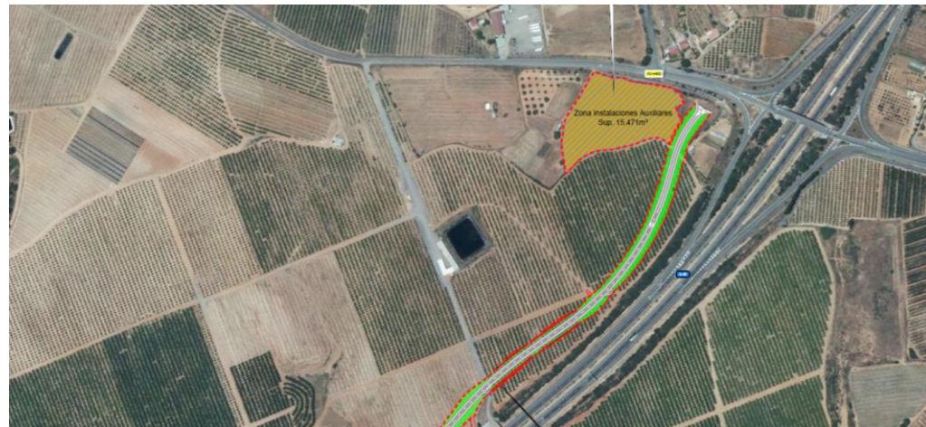
Localización de la Zona de Instalaciones Auxiliares. Fuente: Google Earth y Elaboración propia.
