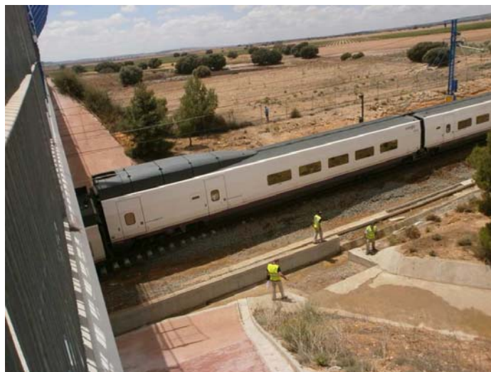
Cambio de sección de cuneta y muro (Fuente: Renfe Operadora)
