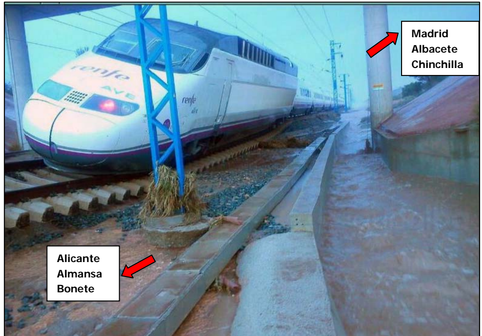
Vista del lugar de los hechos, se aprecia el curso de agua por el lado izquierdo de la vía, según el sentido de la marcha del tren. (Fuente Renfe Operadora)
