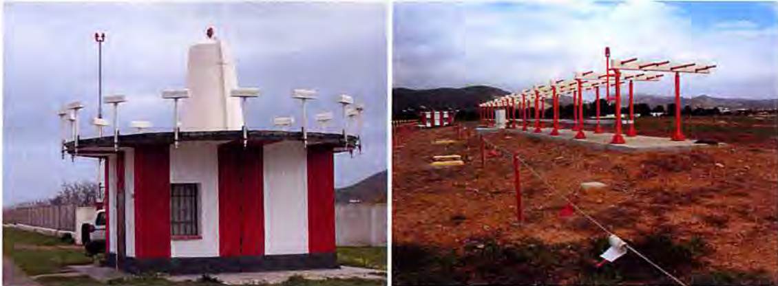
Ilustración 2.22.- VOR/ DME y localizador de la pista 24
