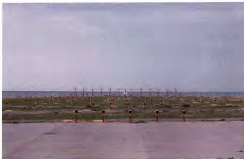
Ilustración 2.7.- Sistema de luces de aproximación de la cabecera 06
