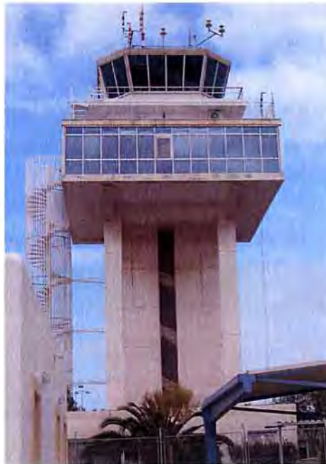
Ilustración 2.20.- Torre de Control
