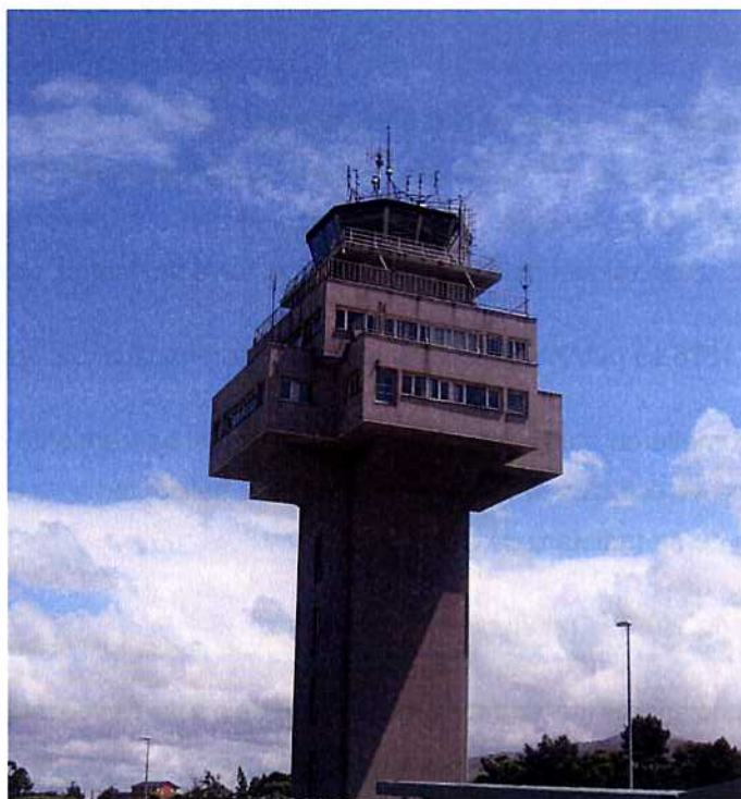
Ilustración 1.2.- Torre de control
