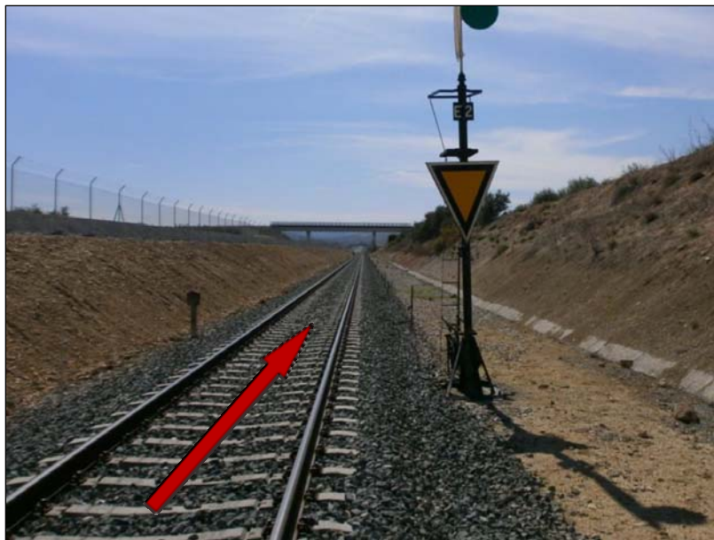
Señal avanzada E2 (lado Granada)
