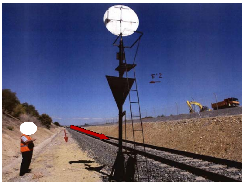
Señal avanzada E´2 (lado Granada)
