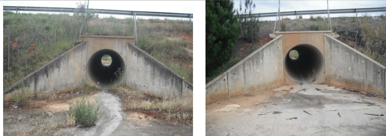
Embocadura ODT existente p.k. 0+044 Eje 1 Glorieta Oeste
