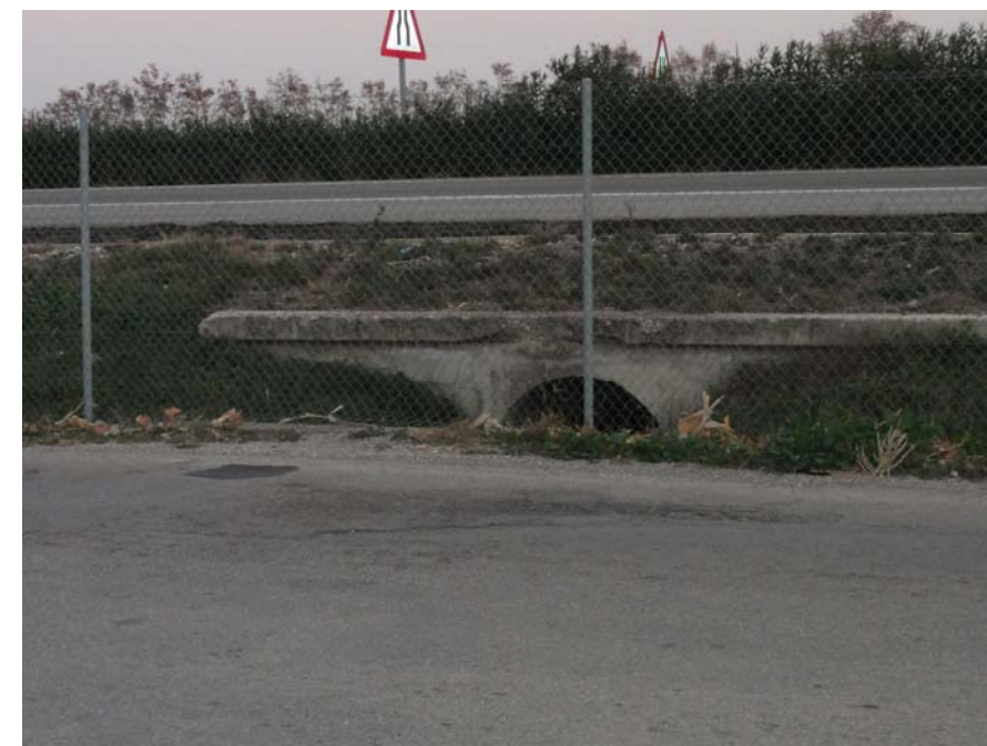
Emboquille obra de drenaje lado oeste, visto desde la calle San Cristóbal.
