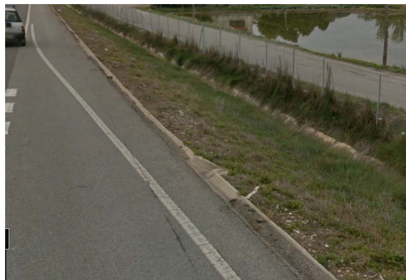
Vista del conjunto cuneta cabeza terraplén – bajante – cuneta pie terraplén.
