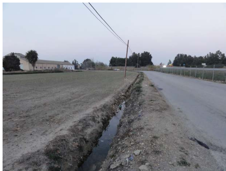
Cuneta camino de servicio lado este.
