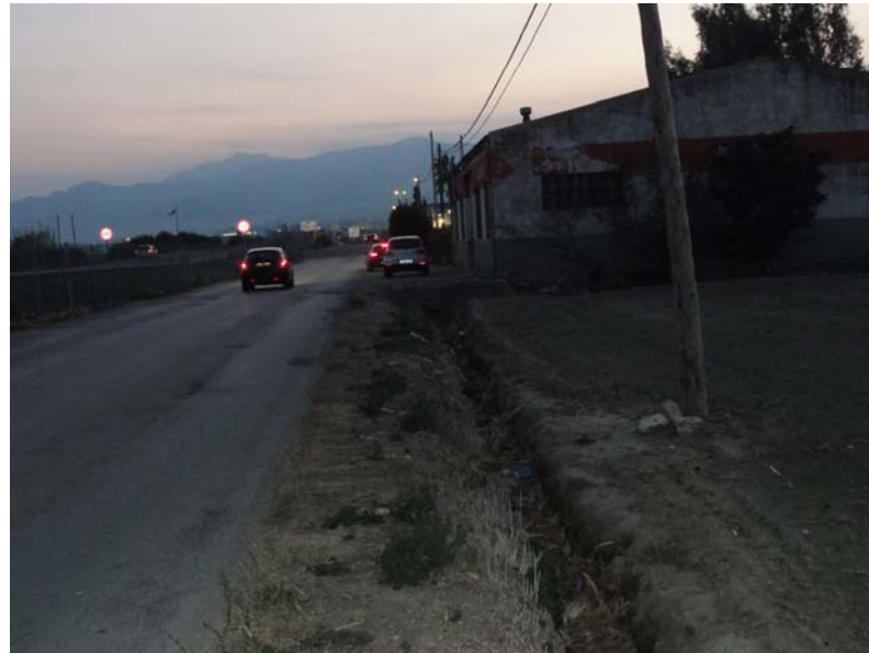
Cuneta calle San Cristóbal.
