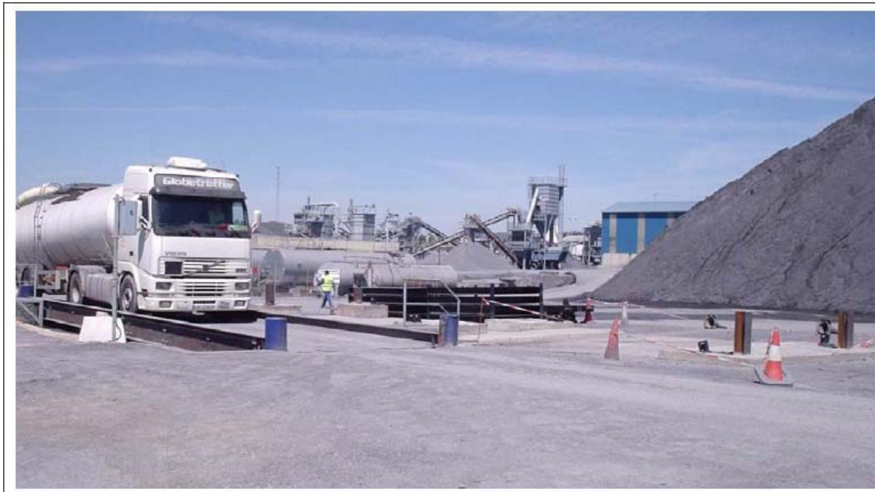
Detalle de las instalaciones de la cantera Geasur
