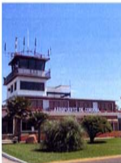
Ilustración 2.12.- Antigua Torre de Control
