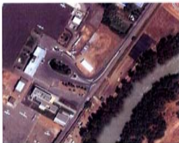
Ilustración 2.18.- Rotonda de acceso al Aeropuerto de Córdoba
