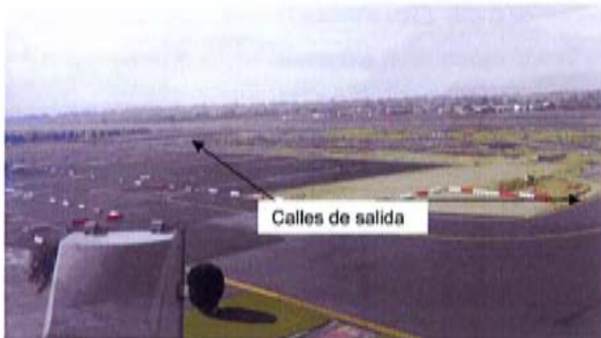
Ilustración 2.7.- Estado actual del campo de vuelos
