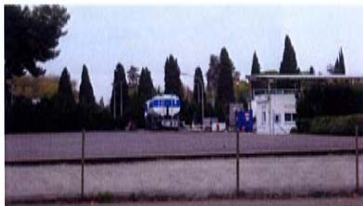
Ilustración 2.17.- Instalaciones del CLH
