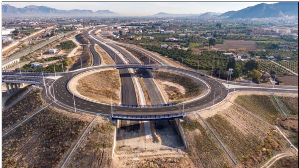
Enlace autovía del Reguerón con Avenida de Levante
