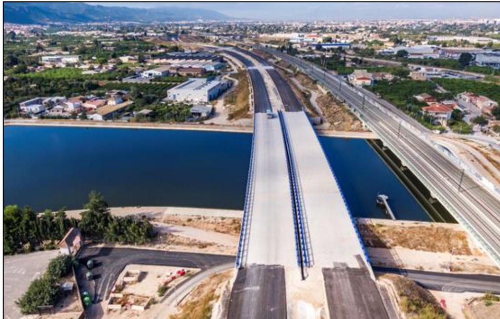
Viaducto en el p.k. 10+600 sobre la balsa de regulación de riego
