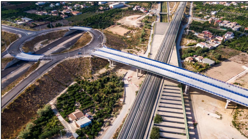
Viaducto en el p.k. 0+760 sobre pérgola del AVE y Canal del Reguerón
