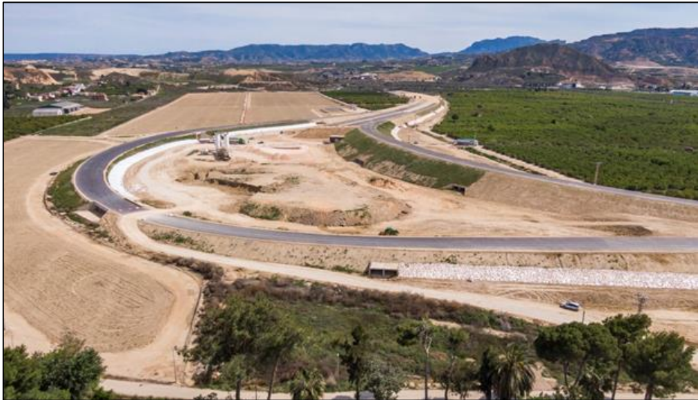
Enlace autovía del Reguerón con la autovía regional RM-1
