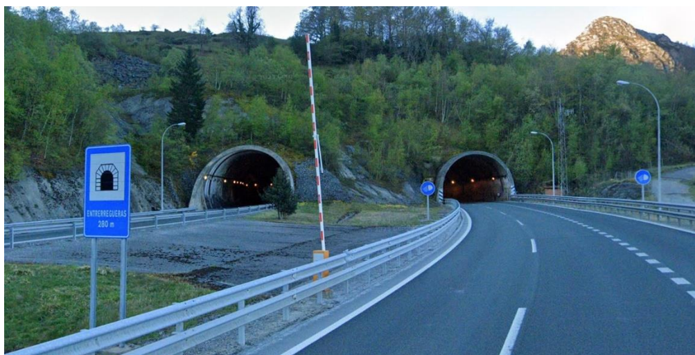
Túnel Entrerregueras Norte - AP-66
